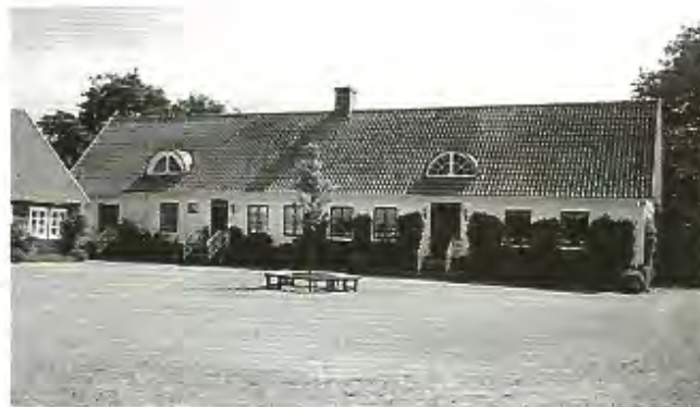
Mangårdsbyggnaden på Svanebäcks gård
