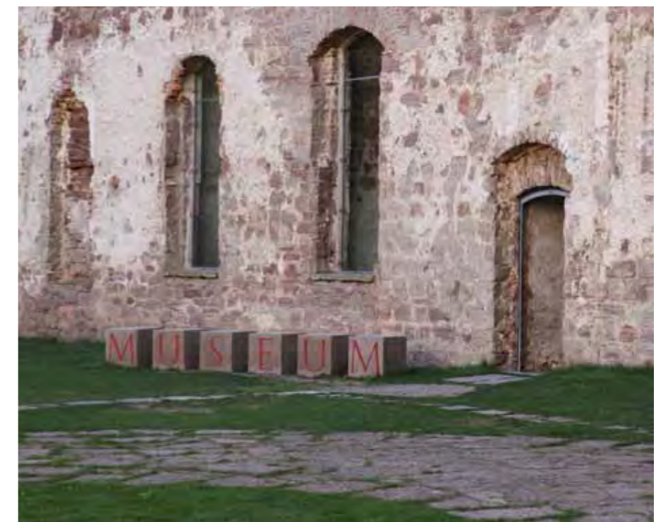
Borgholms slott, Öland, har med moderna tillägg fått stora utrymmen för utställningar, evenemang och gästbud.
