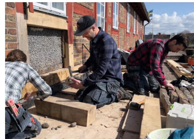
Varsamt har de hackat loss befintligt tegel. När huset ska återställas, hackas gammalt bruk av från tegelstenarna, som därefter sätts tillbaka.
