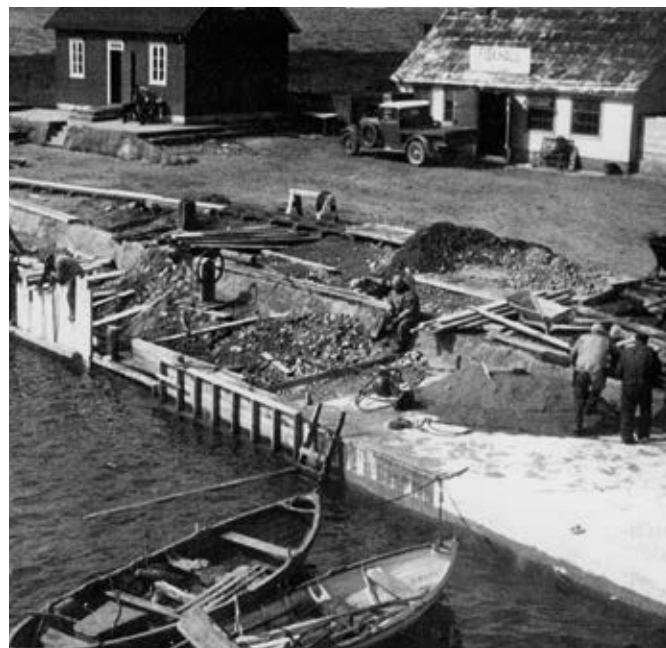
Fiskhallen 1932. Klaffen repareras samma år vid stora hamnreparationen.
