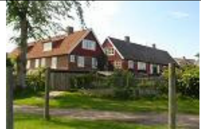
15. Korsvirkesbyggda Skånegården på terrassen började som kringbyggd gård på 1600-talet
